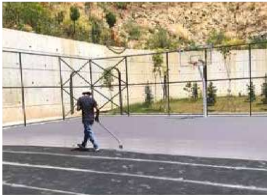
Akrilik zemin kaplaması uygulamasında, resimde görüldüğü gibi özel lastik gelberi kullanılmaktadır.
