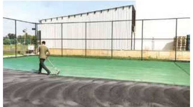
Akrilik zemin kaplaması resimde görüldüğü gibi bu iş için üretilmiş kauçuk gelberi yardımı ile yapılmaktadır.
