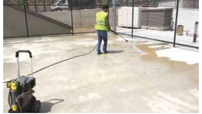
Zemin kaplamasından önce zemin basınçlı yıkama makinası ile yıkanmaktadır.
